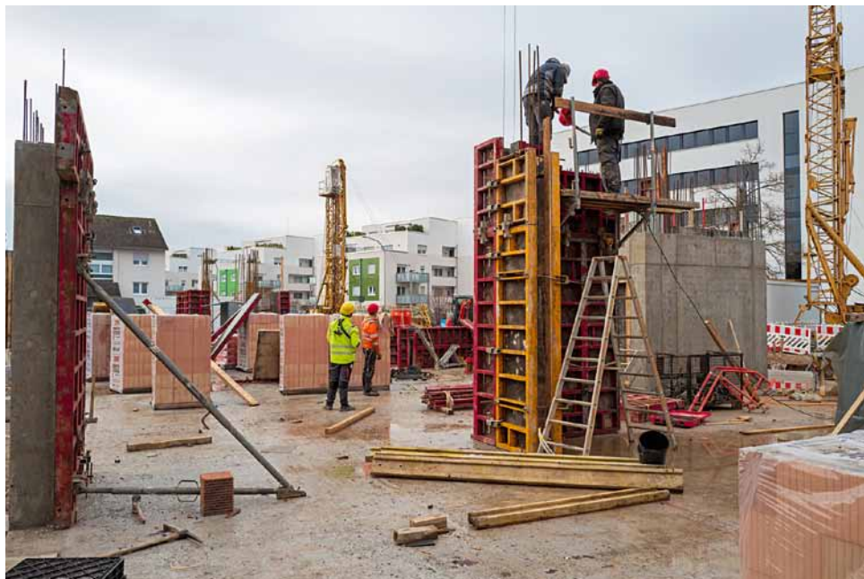
Die Bodenplatte ist gegossen, und die Fahrstuhlschächte und tragenden Wände wachsen in die Höhe.
