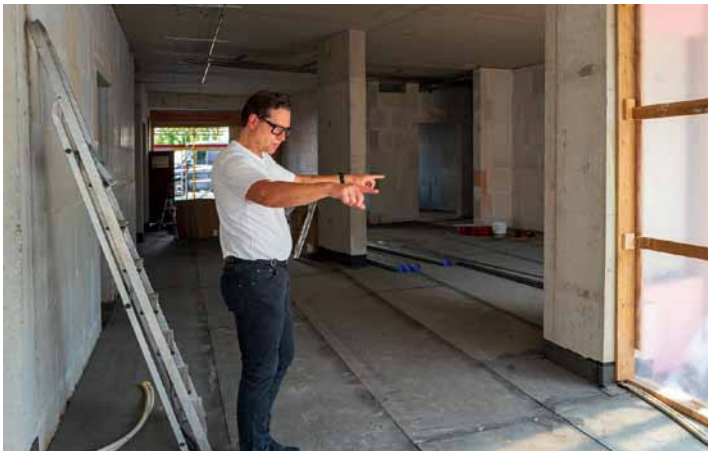
Projektleiter Raimund Schreckenberger bei einer Begehung des Rohbaus.
